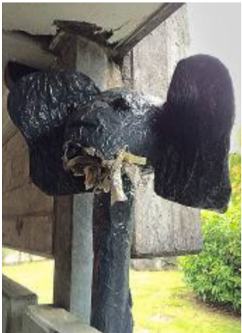
Ohne Rüssel: Der beschädigte Elefant beim Schulhaus.
